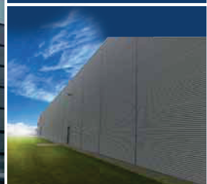
Rivestimento di facciata
