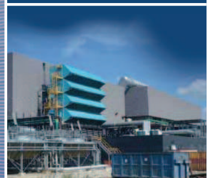
Rivestimento di facciata Lamiere ondulate in alluminio
