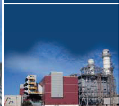
Rivestimento di facciata
