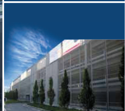
Rivestimento di facciata
