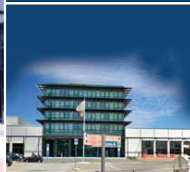
Rivestimento di facciata
